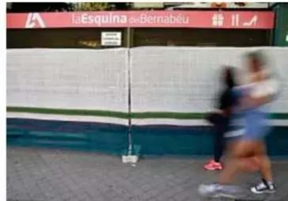
Primeras vallas de la obra del nuevo Bernabéu.
